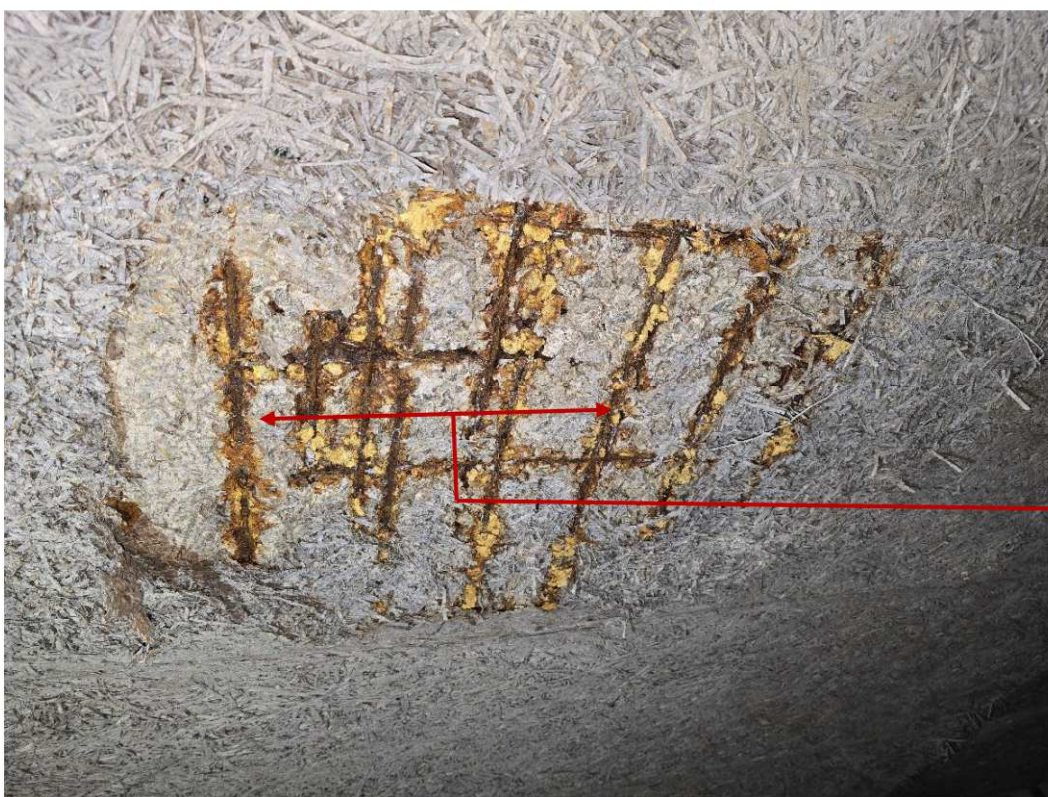
Photo n° 4 : Zone de recouvrement d'armatures
