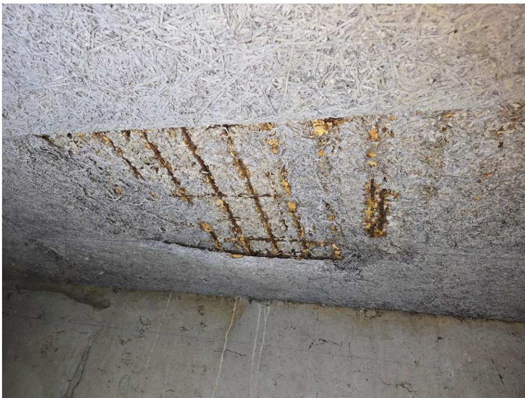
Photo n° 3 : Armatures en sous-face de dalle
