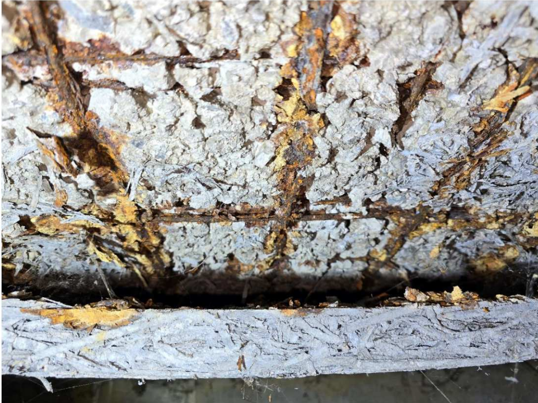
Photos n° 6 : Ségrégation en sous-face de plancher
